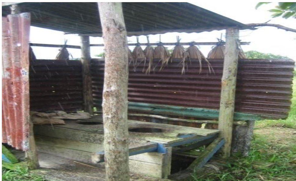
Foto 2. Samuel Bency - Letrina construida con material inadecuada en la franja de 50 metros
