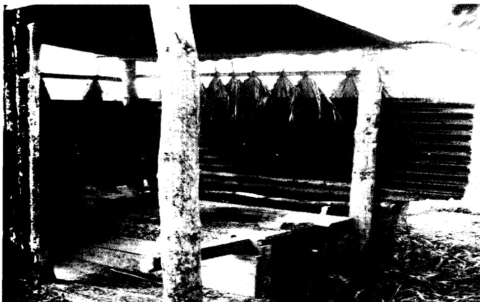
Foto 2. Samuel Bency - Letrina construida con material inadecuada en la franja de 50 metros
