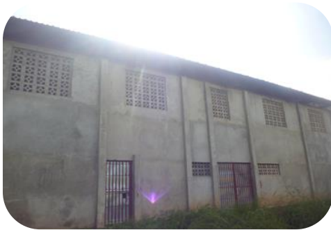
Figura 11 Vista del edificio frontal de la construcción del boxeo.
