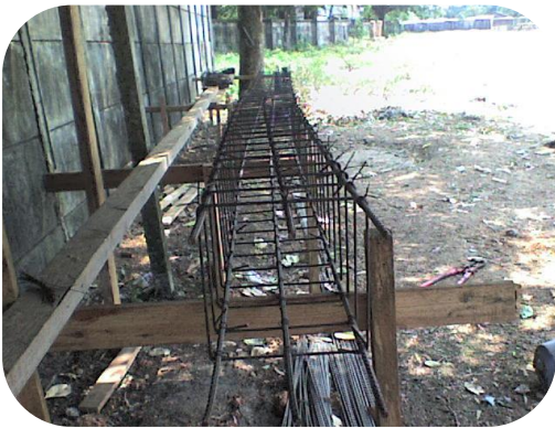
Figura 16 Área de armado del acero de refuerzo con sus apoyos
