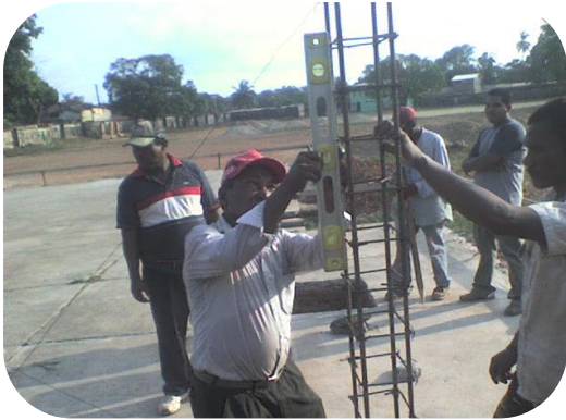
Figura 15 Verificación vertical de columna usando nivel.
