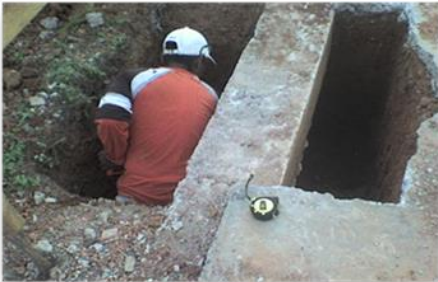
Figura 20 Excavación de columna para zapatas
