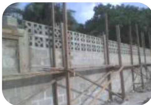
Figura 26 Pedestal fundido, obsérvese aristas bien definidas producto de un buen formateado.
