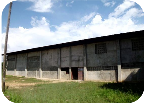
Figura 27 Vista del edificio frontal de la construcción del boxeo
