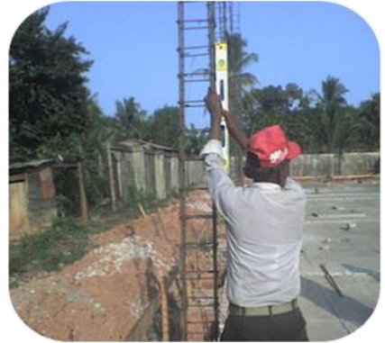
Figura 15 Verificación vertical de columna usando nivel.
