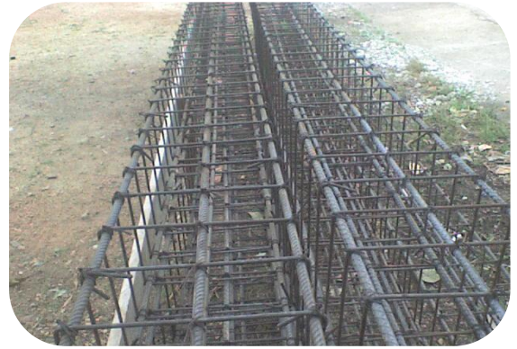
Figura 16 Área de armado del acero de refuerzo con sus apoyos
