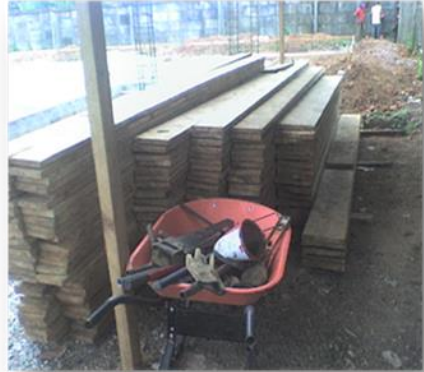
Figura 19 Madera 2X6, 2X8 para entubamiento debido a la inestabilidad del suelo
