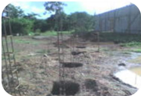
Figura 23 Corte de losa para la colocación de zapatas y columnas.
