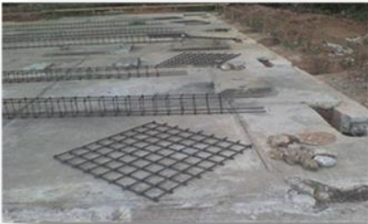
Figura 18 Acero de refuerzo armado según planos y especificaciones técnicas
