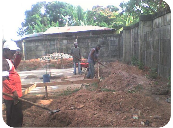
Figura 13. Colocación de Acero (columna), en área del gimnasio, obsérvese lienza de alineamiento de columnas
