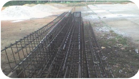
Figura 17 Rotura de Viga A sísmica, para colocación de columna de apoyo
