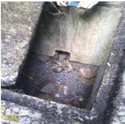
Fotografía. 15 pila de captación de almacenamiento de agua donado por Alcaldía Municipal.
