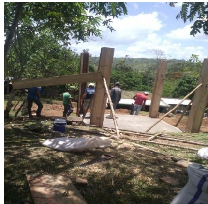
Fotografía. 16 construcción del nuevo tanque
