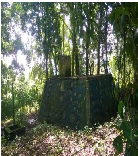
Fotografía. 1 pila de almacenamiento de Agua potable en col: Providencia
