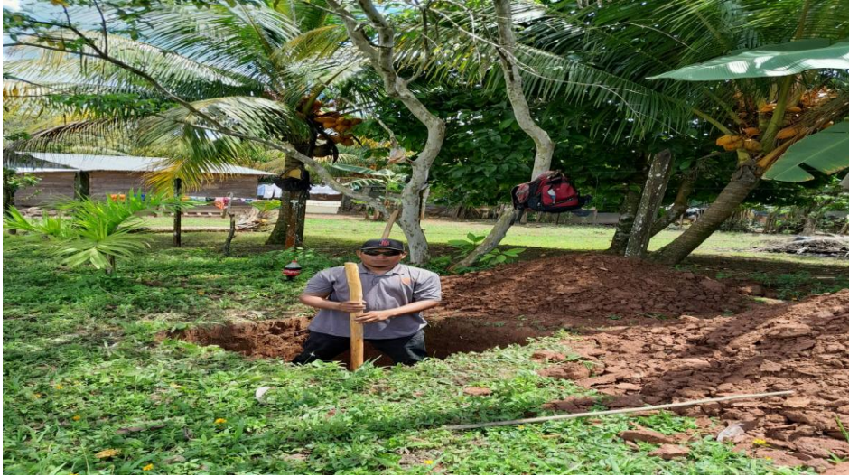
Ilustración 11 Excavación de la calicata en el sitio del proyecto. Fuente propio.
