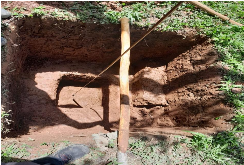
Ilustración 12 Calicata de 1.00x1.00x1.50 de profundidad. Fuente propia.
