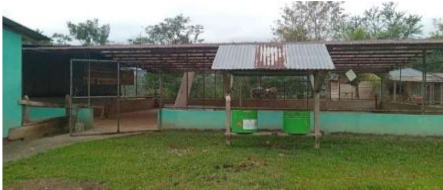
Instalación de secado
