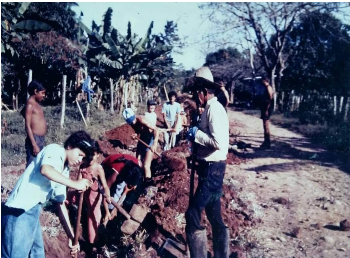
Fotografía N° 15, Pueblo del Coral, en la instalación de Puestos de Agua Potable. Tomada de la página de la Alcaldía municipal del Coral.
