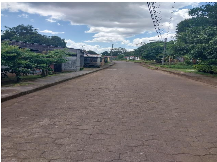
Fotografía N° 11, Calles adoquinadas de la Zona N° 1. El Coral, Chontales. Tomada por Yudyelky Aranciny y Yurisma Lazo el 18 de Enero de 2023.
