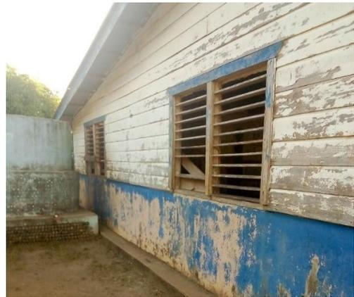
**FIGURA 43. PRECIANAS Y PINTURA EN MAL ESTADO**
