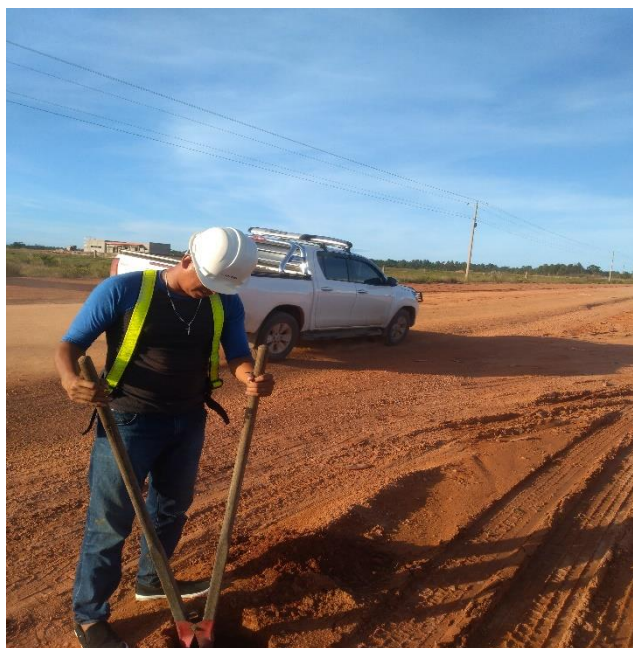
Foto de sondeo en el empalme del hospital Regional en la estación 1+800 y 2+000
