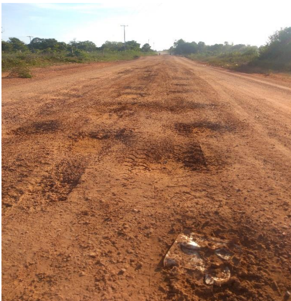
Fotos del Estado de la calle actual
