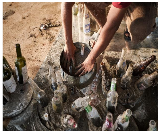
Imagen 3. Construcción de las galletas provisto de cuello de botella
