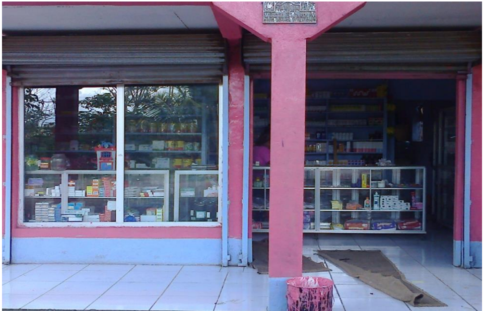
Fotografía 1. Instalación de la farmacia Sinaí, Santa Rita municipio de Mulukukú, tomada por Ismael Centeno Garzón, 24 de diciembre, 2014.
