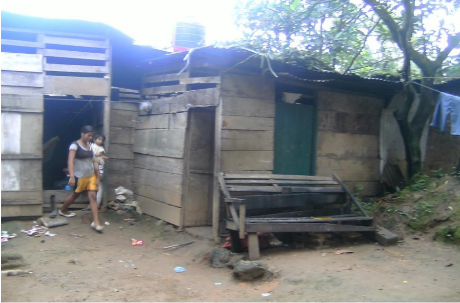
Foto N° 15. Casa de pensionado en mal estado Fotografía: Lisseth Torrez, Karla Amador 22/12/2011
