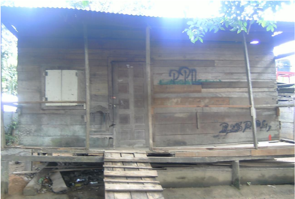
Foto N° 14. Casa de pensionados en mal estado del barrio Lucia Montoya.
