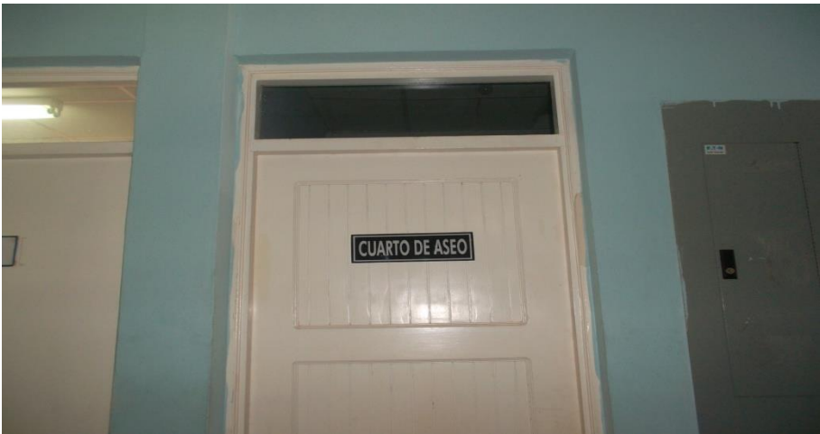
Foto No. 2: Área de conserje (servidor) donde se ubicara el servidor y el switch de 24 puertos
