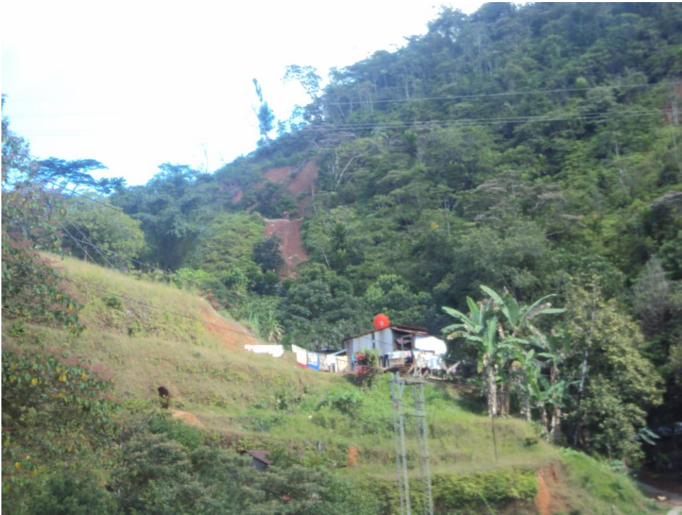
Viviendas ubicadas en las laderas, bajo la amenaza de los deslizamientos
