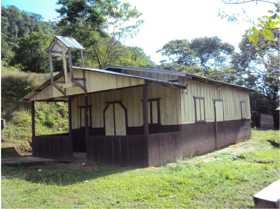
Capilla católica que sirve de albergue en situaciones de emergencia
