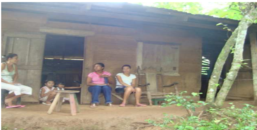
Fotografía tomada por Yadeysy Zelaya el día 05 de septiembre 2010, donde se puede observar las condiciones de las viviendas del barrio Rigoberto López.
